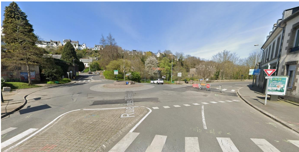
Illustration n°6 : vue du carrefour giratoire non sécurisé où débouche la rue du Légué (à droite sur la photo, derrière les barrières condamnant l'accès pour travaux)
